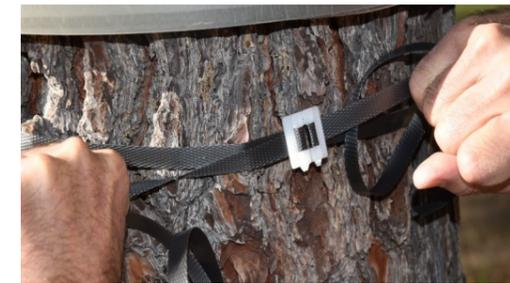
Entourez le tronc de l'arbre avec le feuillard à **5 cm au-dessous du collier**. Faites une boucle avec une extrémité de ce dernier. Insérez-la dans le cadre de *l'attache rapide* autour de la tige puis la rabattre. Répétez l'opération avec l'autre extrémité.
